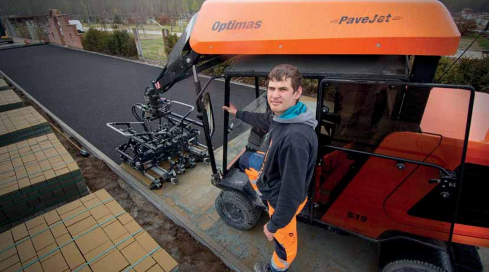
Beim Verlegen von Betonpflaster bedient Leonhard Wolf die Pflastermaschine.
